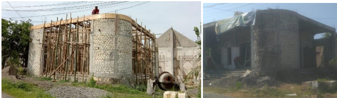
Gambar 18. Pengecoran Plat Atap
