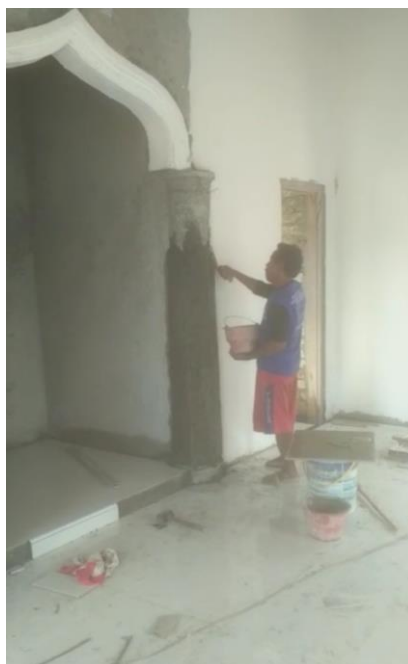
Gambar 19. Pengacian Dinding
