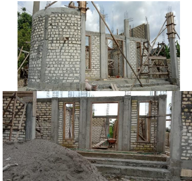
Gambar 17. Pemasangan Dinding
