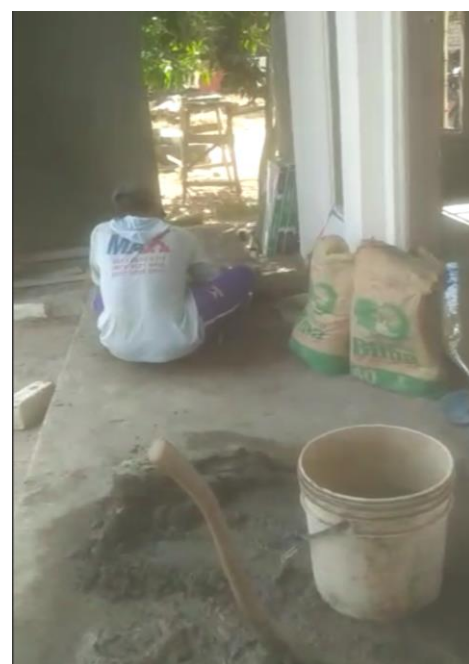
Gambar 20. Pemasangan Lantai Teras
