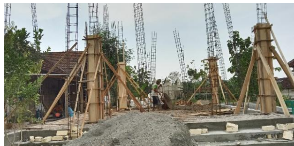
Gambar 16. Pengecoran Kolom
