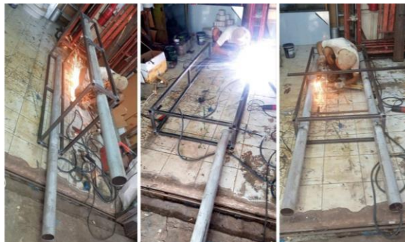
Gambar 8. Pembuatan Struktur Tiang
