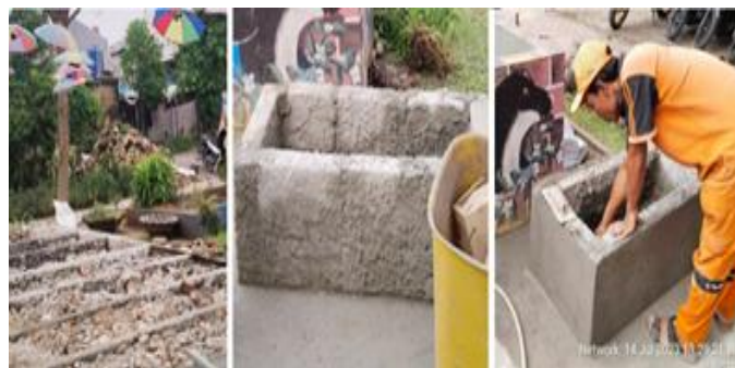
Gambar 11. Pondasi Totem Sign
