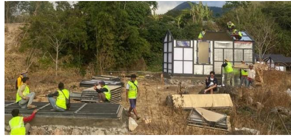
Gambar 10. Pengaplikasian Dinding Modular Sumber: Dokumentasi Penulis, 2023
